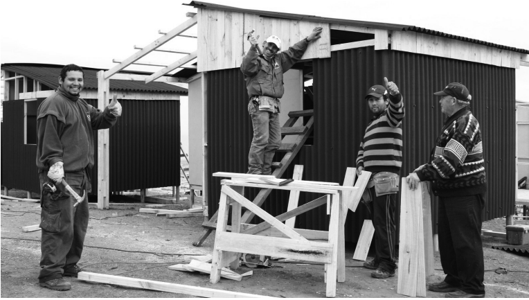
Construcción de refugios temporales – Terremoto en Chile 2010
